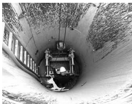
写真-2 ジャッキ部据付け状況
