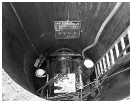
写真-3 鋼管削進状況
