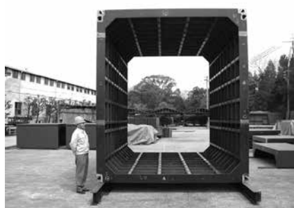
写真－5 鋼殻組立状況
