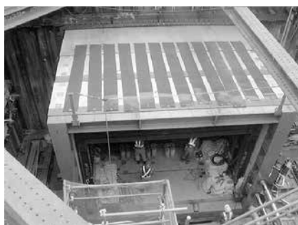
写真－6 カーテン鋼板の取付状況
