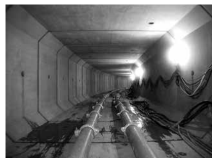
写真－7 推進中の函内状況（曲線部）
