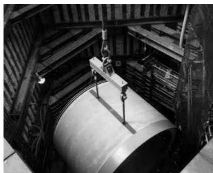
写真一 ソイルセメント柱列杭立坑
