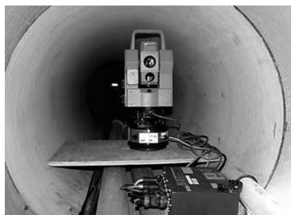
写真-1 管内設置状況
