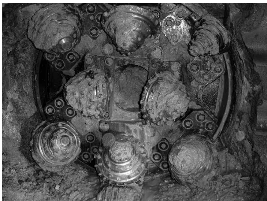
写真-1 掘進後ビット磨耗状況
