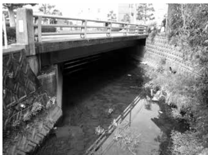
写真－1 橋梁下部
