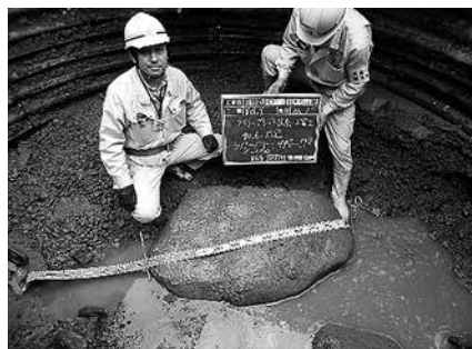
写真一1 回収および発進立坑において礫を確認
