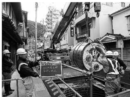
写真一2 掘進機吊下し
