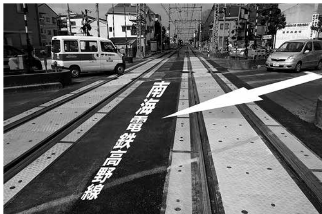
写真－2 （南住吉加賀屋幹線-7）南海電鉄高野線交差
