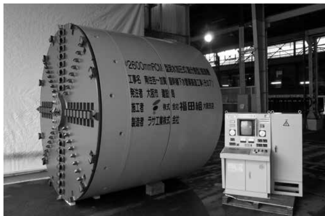
写真－1 （南住吉加賀屋幹線-7）掘進機
