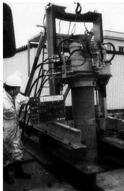
写真-1 施工状況
