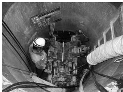
写真-1 ストライク工法機STM-1535 φ1,500mm立坑内据付状況
