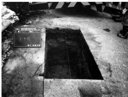
写真-3 舗装版撤去
