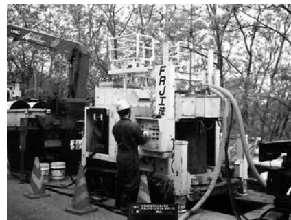
写真-5 推進状況
