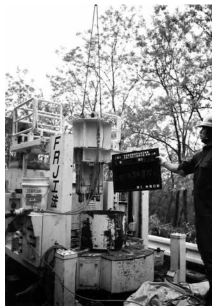
写真-8 管芯探査
