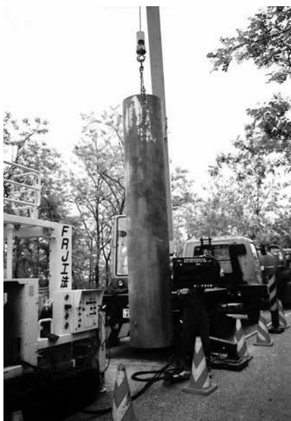
写真-6 鋼製さや管セット
