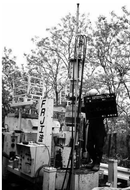
写真-10 コア抜き装置
