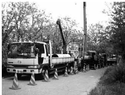
写真-4 施工状況
