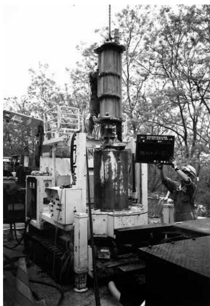
写真-7 掘削機セット
