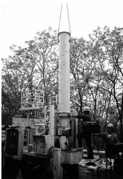
写真-9 ガイド管挿入
