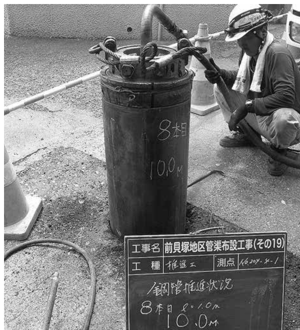
写真－2 立坑が不要な地上発進状況
