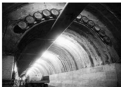
写真ー1 掘削断面上部のルーフ形成例
