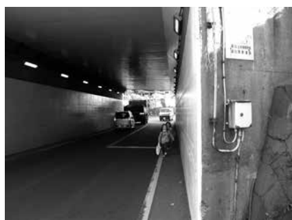
写真-1 アンダーパス現状
