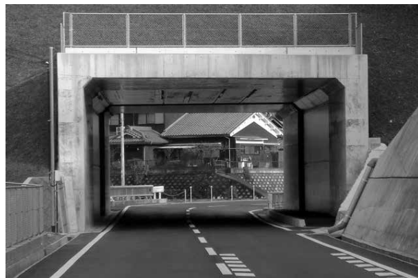
写真-2 箱形トンネル形式の施工例
