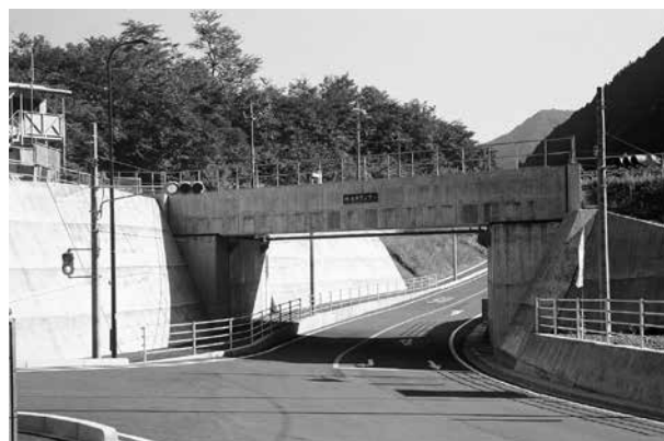
写真-1 下路桁形式で上下分離形式の支承を有する構造の施工例
