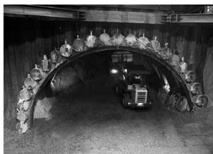
写真-3 パイプルーフ完成（トンネル掘削状況）
