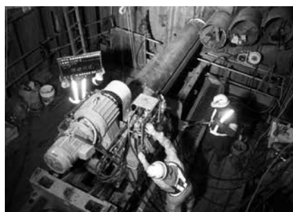
写真-2 推進状況（2号機）
