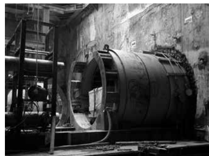
写真－3 ダミー管の推進状況
