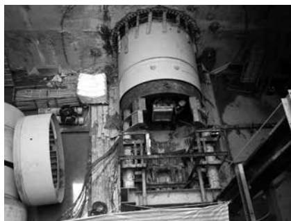
写真－2 掘進機挿入とダミー管
