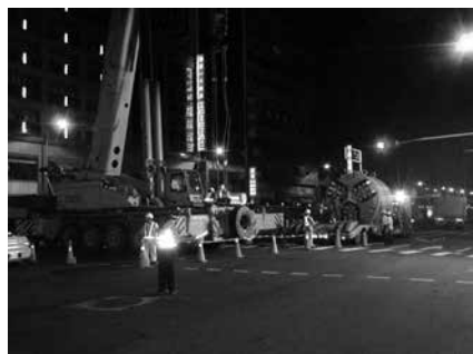
写真－1 掘進機搬入状況
