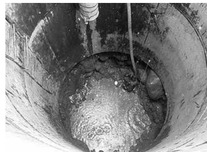
写真-5 中間立坑掘削による先導体回収（線形不良トラブル）
