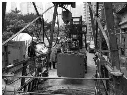
写真-3 元押装置の立坑搬入
