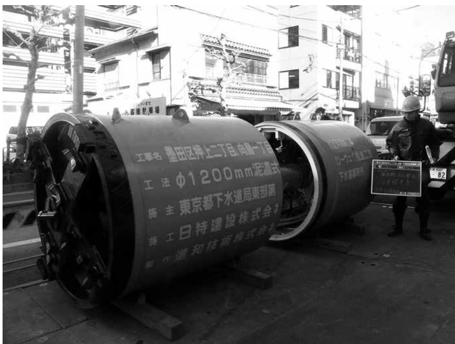
写真-1 残置回収型泥濃式掘進機
