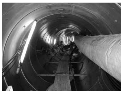
写真-5 推進中の管内（R=50m）
