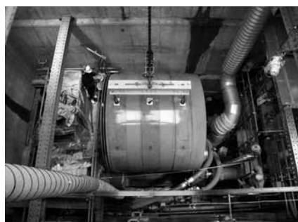
写真-4 呼び径2600のR=50m部に用いた1/3管
