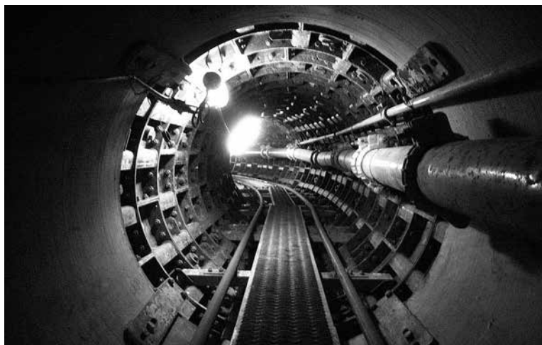
写真-1 シールド工法と推進工法の切替状況
