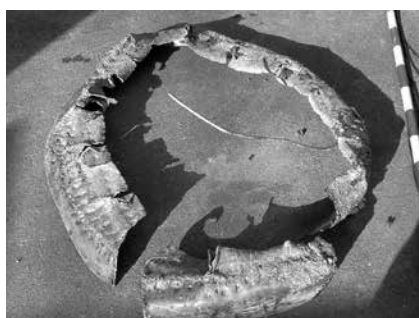
写真-3 継輪切断状況
