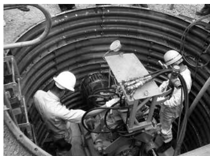
写真-1 小型立坑 発進状況
