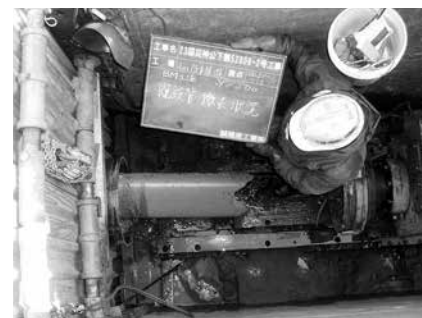
写真-3 既設管回収状況
