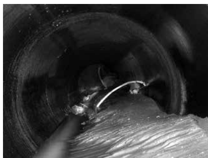
写真-2 削進中の鋼管内の状況(中央に切削された卵形管が見える)
