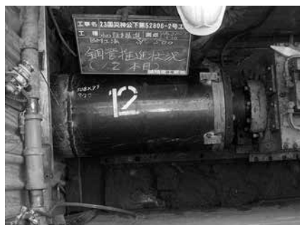
写真-1 鋼管削進状況
