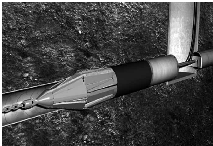
図-1 EXP工法の施工状況CG
