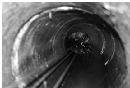
写真ー2 クラッキングヘッドを到達側から 牽引している状況
