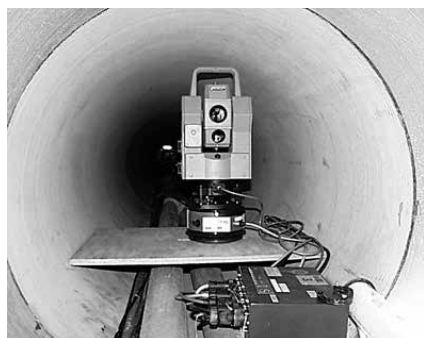
写真-1 設置状況
