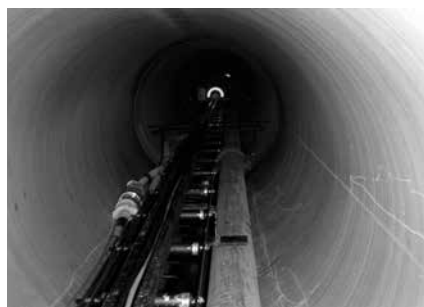
写真-3 管内ロールコンベアレール上のCCDカメラセンサ
