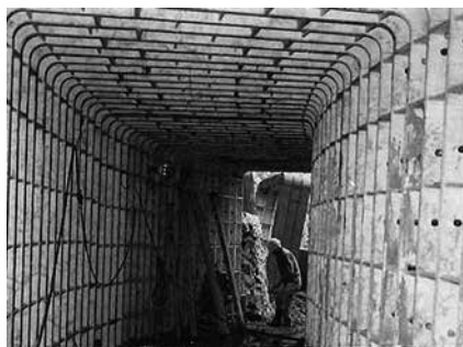
写真-1 混合推進(曲線部)
