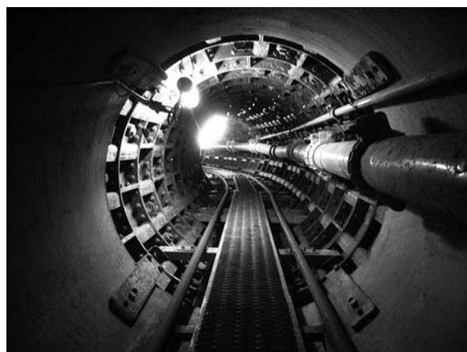
写真－3 シールド工法と推進工法の切替状況
