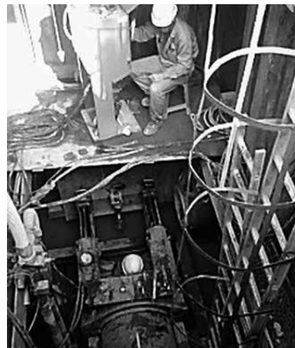
写真-1 コブラ工法発達立坑内(韓国百済)
