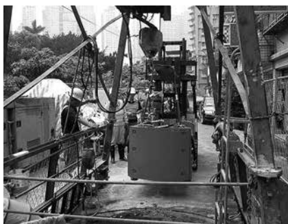
写真－3 元押装置の立坑搬入
