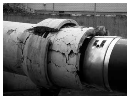
写真-3 破碎状況
