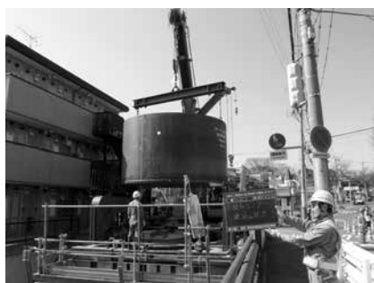
写真－5 ケーシング建て込み・溶接
