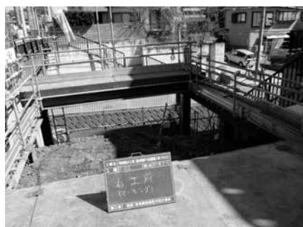
写真－2 作業用鋼台の設置
