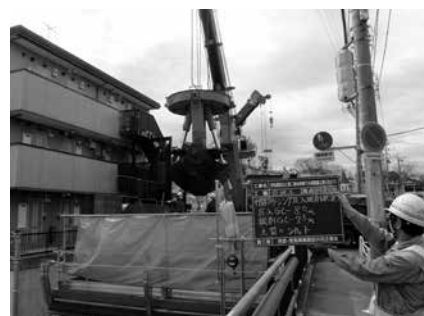
写真－6 ケーシングの揺動圧入および掘削
