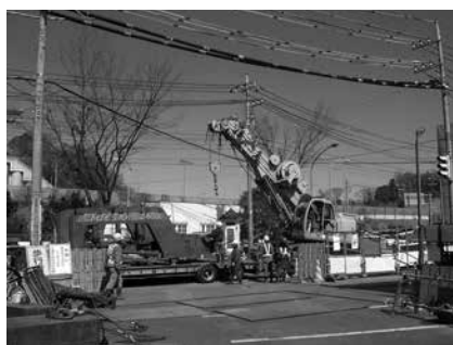
写真－3 圧入掘削機搬入・設置
