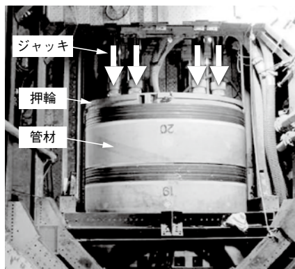
写真-1 φ3,000mm 半管の推進設備
