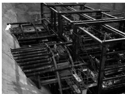
写真-1 山岳坑口防護パイプルーフ
