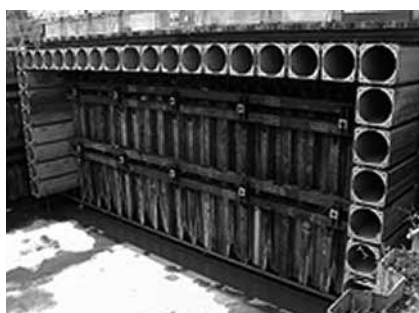
写真ー4 箱型ルーフ工法
