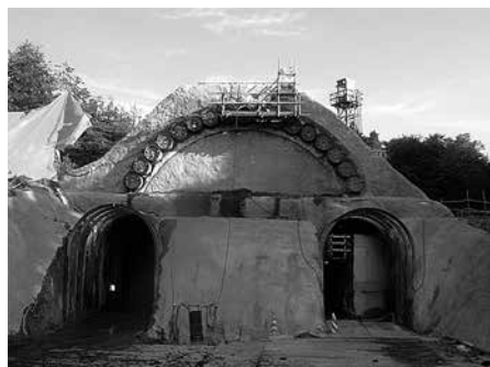
写真-1 アングルモールパイプルーフ工法の適用事例
