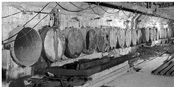
写真-2 アンダーピーニング適用パイプルーフ施工完了状況
