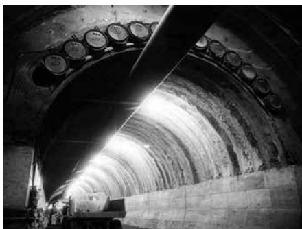
写真-1 アングルモールパイプルーフ工法の適用事例
