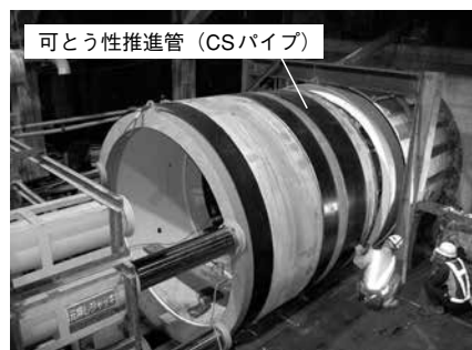
写真-4 可とう性推進管(CSパイプ)
