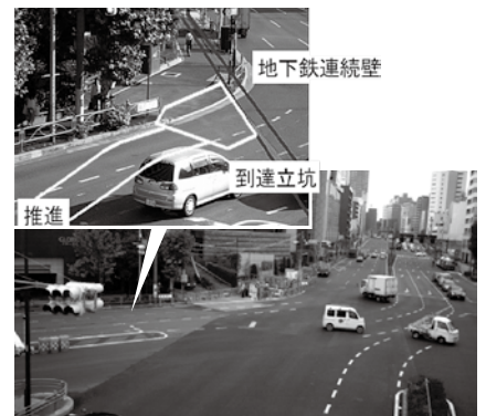
写真－3 到達立坑周辺状況
