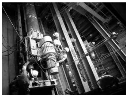
写真-1 THパイプルーフ工法 施工状況
