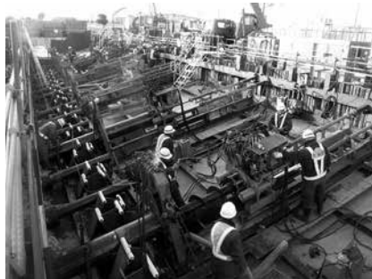
写真-3 タイロッド工法 施工状況
