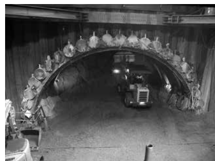
写真-2 THパイプルーフ工法 施工完了
