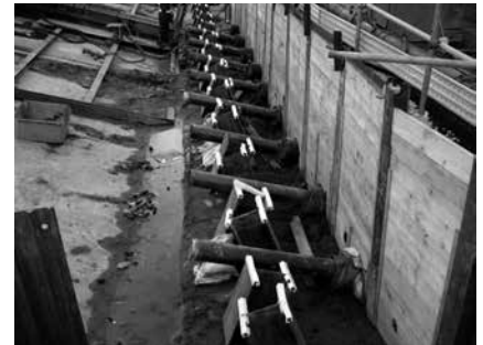
写真-4 タイロッド工法 施工完了
