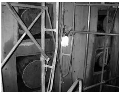
写真-3 到達側での推進完了の状況
