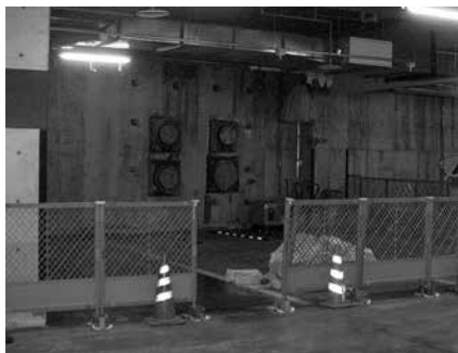
写真-2 発進側での推進完了の状況
