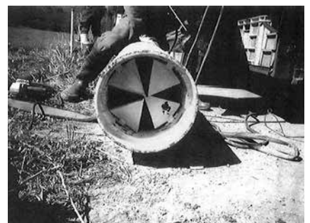
写真-7 特殊加工した先端部
