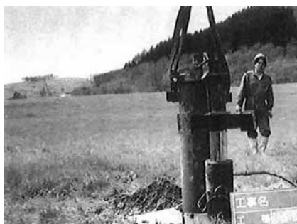
写真-6 鋼管の引き抜き
