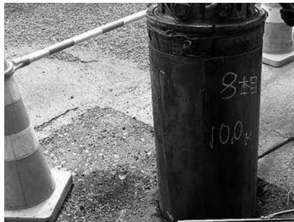
写真-2 既設管に向けて鋼管削進
