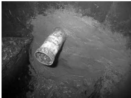
写真-1 管口を閉塞し注入口を取付ける
