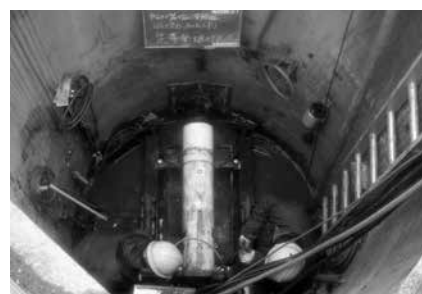
写真-3 先導管据付
