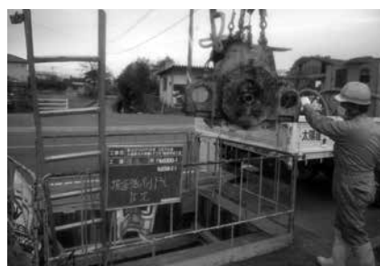
写真-2 本体吊降し
