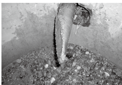
写真-4 礫対応型リード管 到達状況
