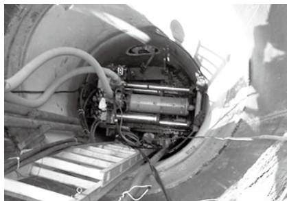
写真-1 二工程目発進状況
