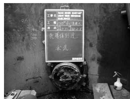
写真-5 先導体到達状況
