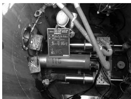
写真-3 推進状況 (115本目)
