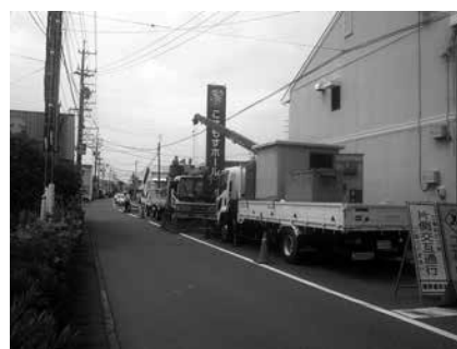
写真-4 車上プラントによる施工
