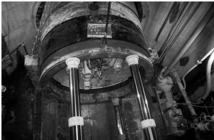
写真-1 後続管設置状況例
