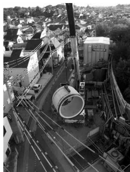
写真-1 発進基地全景
