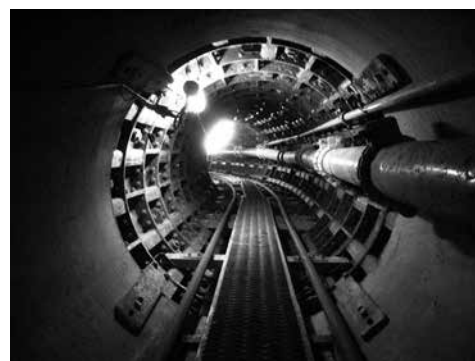
写真－2 推進管→セグメント
