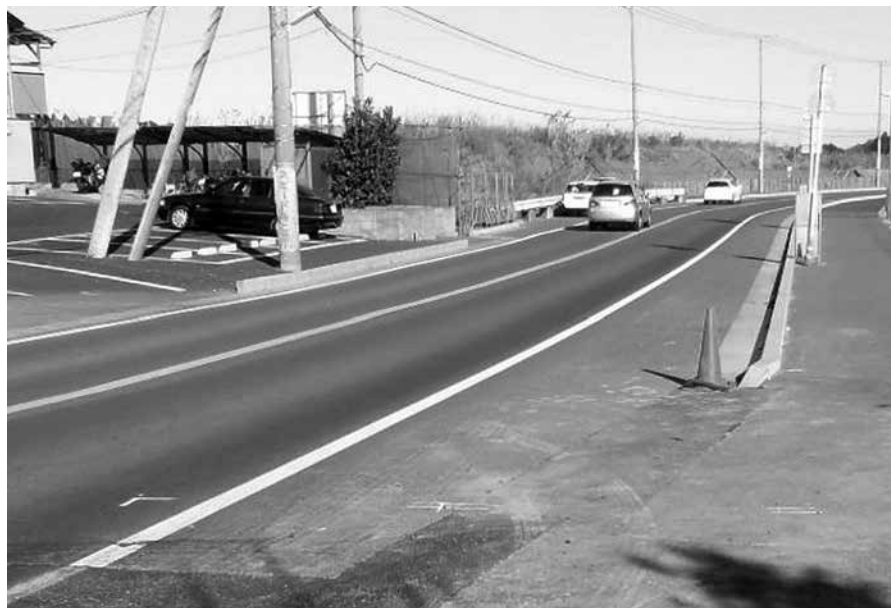
写真-1 現場状況
