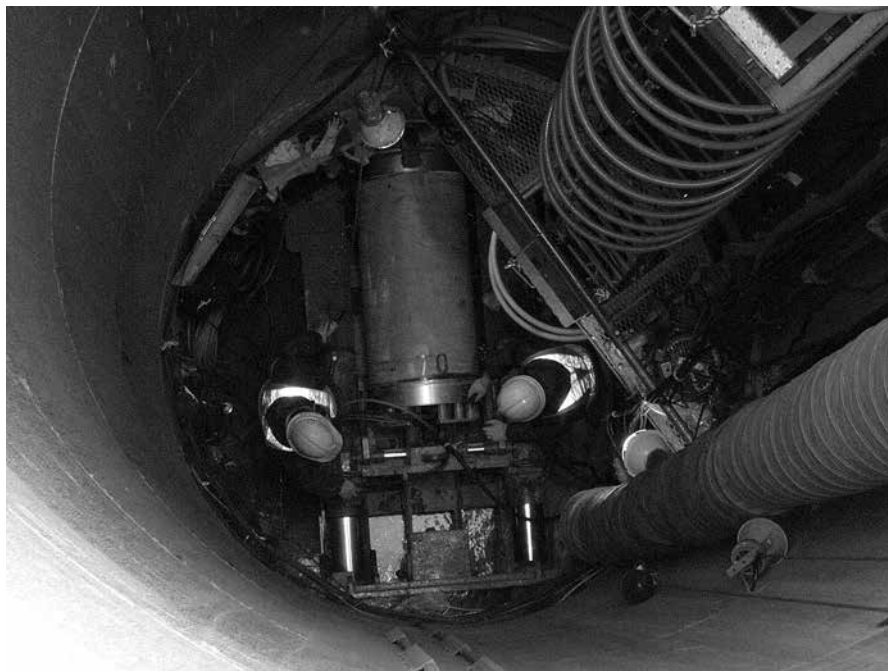
写真-2 現在の現場での発進立坑内作業状況
