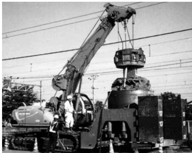
写真-1 鋼製ケーシングの工法例
