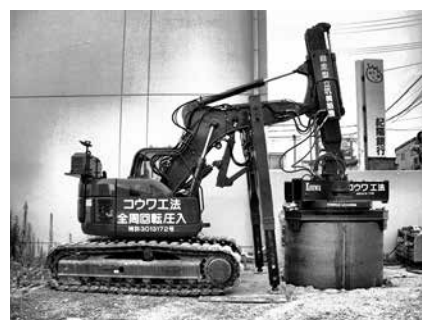
他工法で困難と判断された現場でも施工可能なコウワ工法
