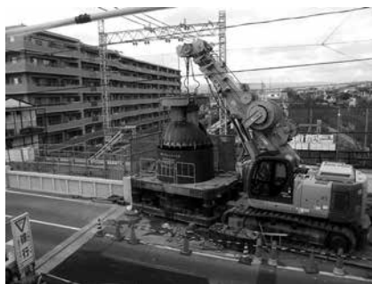
土留立坑からスタートしたケコム工法
