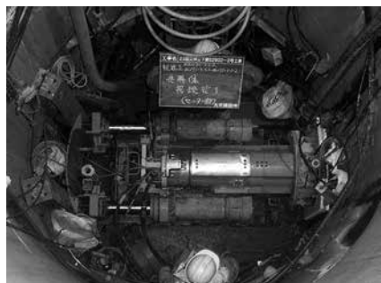
狭い立坑内での作業状況
